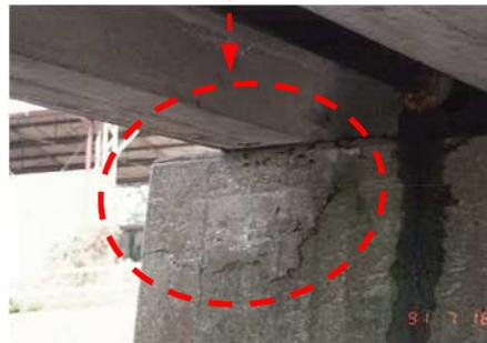
・ 沈下、傾斜、移動(パラペットに損傷が生じやすい)
