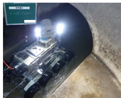
下水道管路の調査状況
