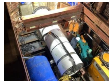
内宮幹線管渠延伸工事
