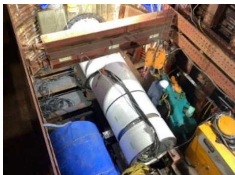
内宮幹線管渠延伸工事
