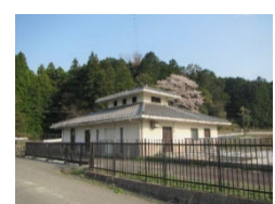
廃止側: 東貝野地区処理施設(いなべ市)
