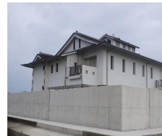
三渡川ポンプ場の防潮壁
