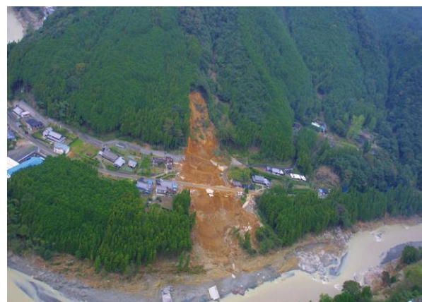
平成 16 年豪雨災害 (旧宮川村地内)
