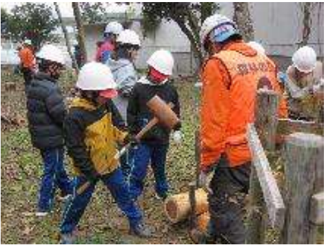
ベンチを設置している様子
