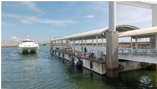
図 1.2 贄崎地区（津なぎさまち）
