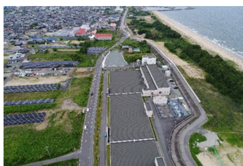
志登茂川浄化センター
