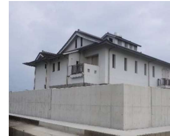
三渡川ポンプ場の防潮壁
