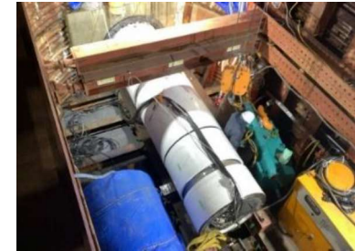
内宮幹線管渠延伸工事
