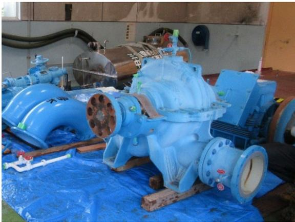
分解点検中の高野浄水場送水ポンプ設備
