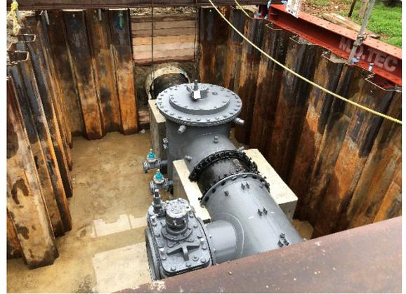
不断水工法<sup>※</sup>による制水弁設置状況
