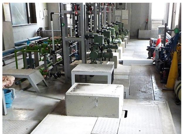
更新中の播磨浄水場苛性ソーダ注入設備\*
