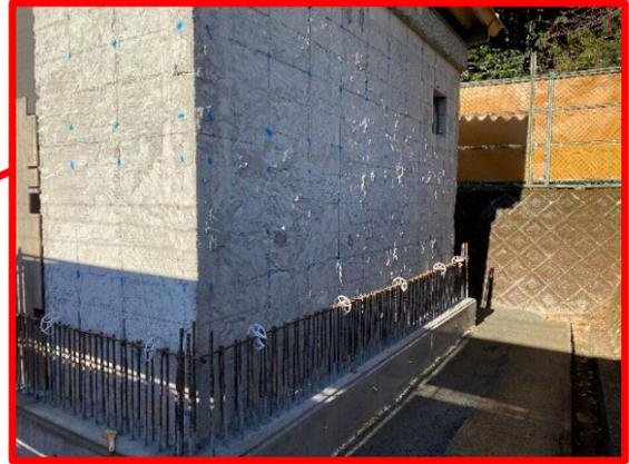
建屋側壁 増し厚の施工状況
