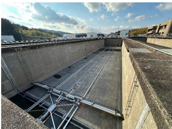
更新中の多気浄水場沈澱池汚泥掻寄機
