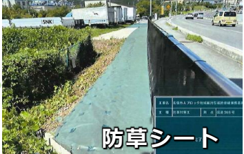
施工箇所の例 道路沿い法面 など
