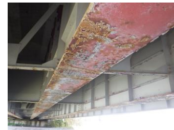
再塗装（損傷少）
