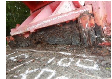
部材交換（損傷大）
