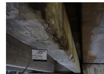
断面修復（損傷大）
