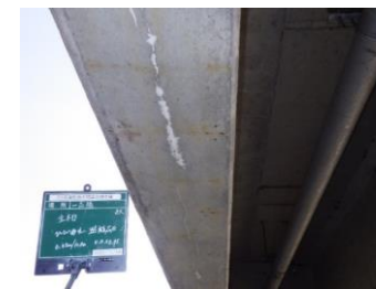
防水措置（損傷少）
