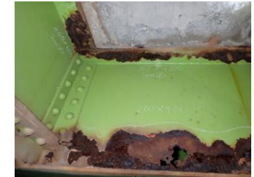
当て板補修（損傷大）
