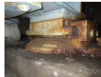
防錆処置（損傷少）
