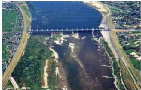
木曾川大堰付近(平成6年渇水時)
