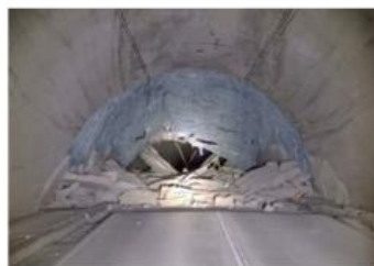
<国道249号 中屋トンネル>
