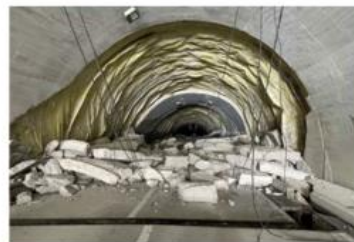
<国道249号 大谷トンネル>
