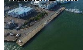
耐震強化岸壁の改修
