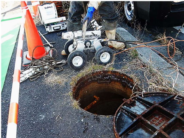
自走式カメラによる管渠内部点検
