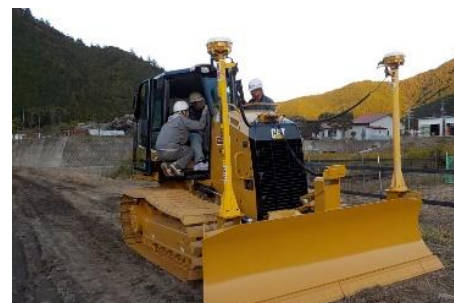
ICT活用工事（ICT建機施工）
