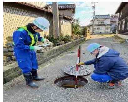
一次調査状況 （マンホール上部から確認）
