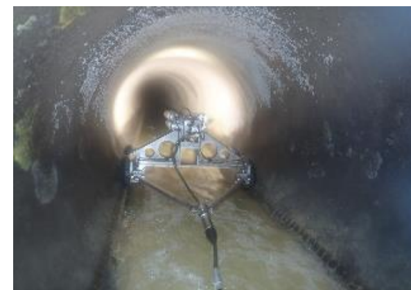
二次調査状況 （管内TVカメラ調査（イメージ））
