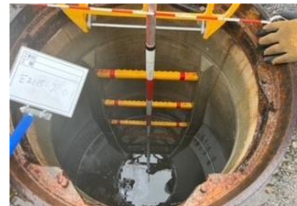
一次調査状況 （マンホール内確認）
