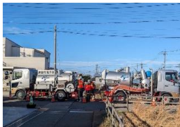
二次調査状況 （超高圧洗浄車(左)と強力吸引車(右) による管清掃）
