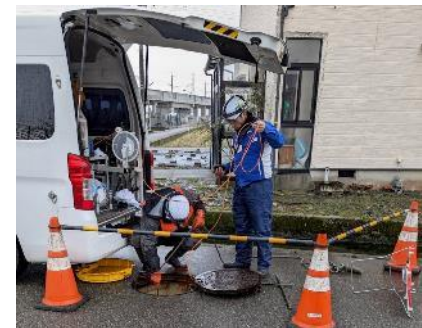
二次調査状況 （管きよ内へカメラを挿入）
