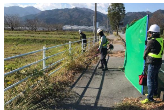
道路の除草作業 (松阪市)
