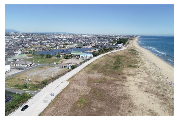
上野地区海岸高潮対策事業 (津市)
