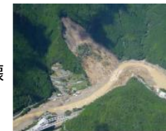
深層崩壊発生直後 (五條市清水地区)
