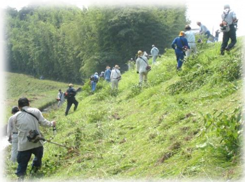
ため池法面の草刈り作業
