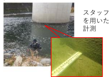
潜水調査による河床洗堀の把握
