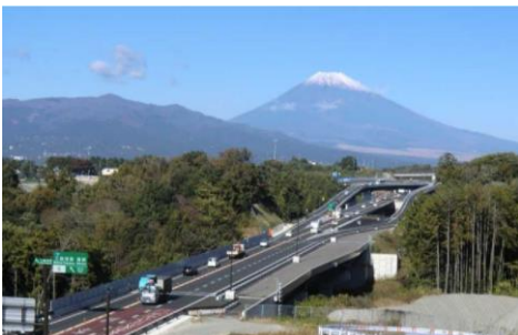
広域的な移動を支える道路
