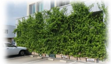
県桑名庁舎の グリーンウォール設置
