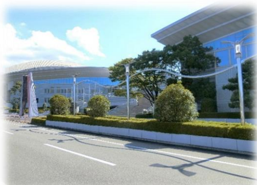
施設周辺の植栽 (三重県営サンアリーナ)
