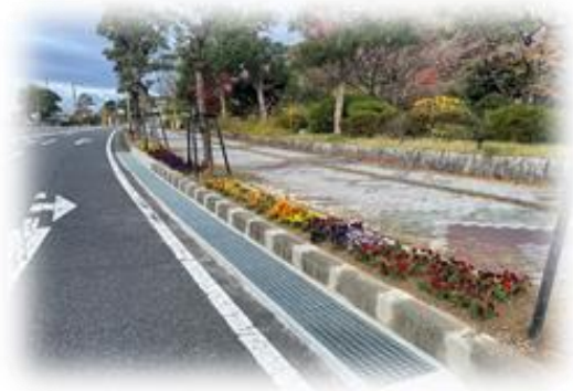
雨水浸透設備（県庁前）
