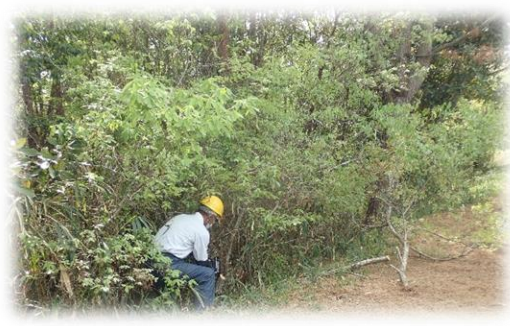
歩道沿い除伐状況
