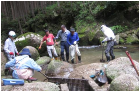
【頭首工の土砂撤去の様子】
