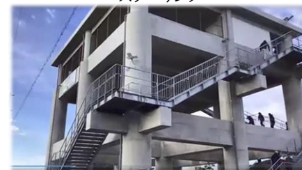
津波避難タワー（志摩市）
