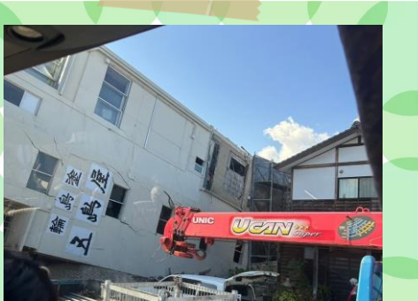
崩壊したビル
