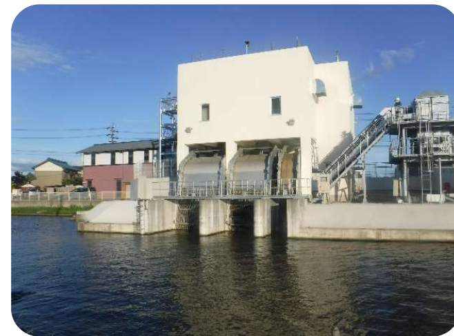
排水機場の整備
