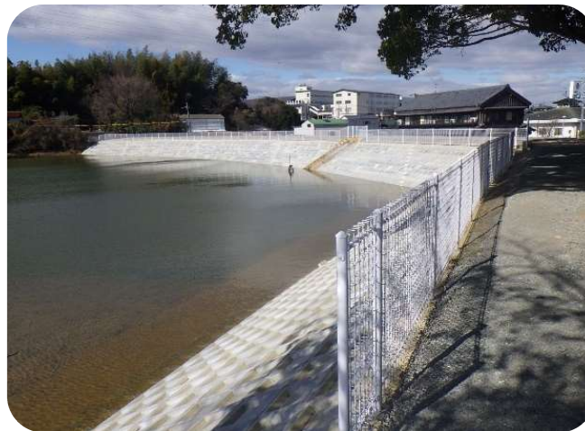
農業用ため池の整備
