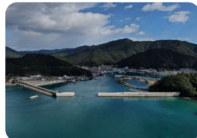
防波堤の整備
