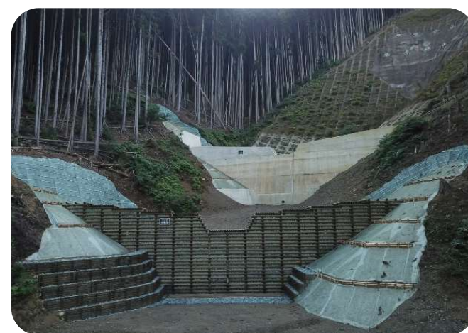
治山施設の整備
