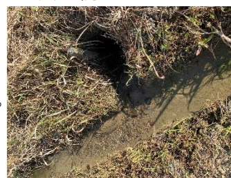
排水口と明渠がつながっている 明渠の角がつながっている
