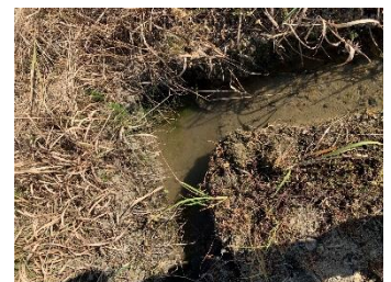
排水口と明渠がつながっている 明渠の角がつながっている
