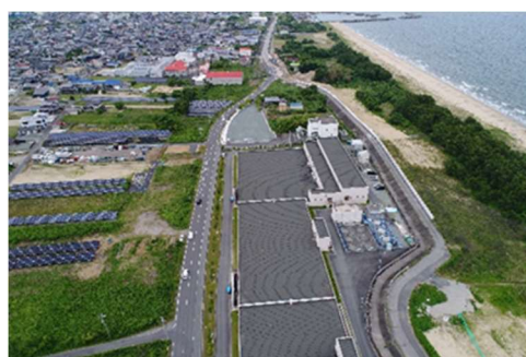
志登茂川浄化センター
