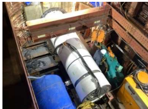
内宮幹線管渠延伸工事
