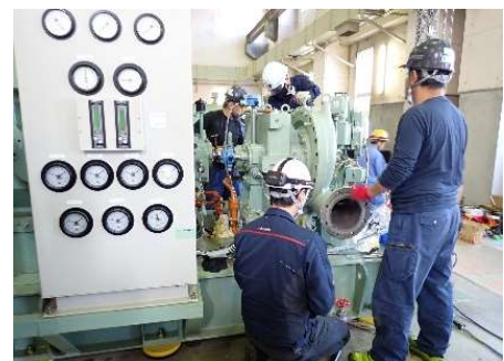
下水処理設備の点検状況
