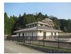
廃止側: 東貝野地区処理施設(いなべ市)
