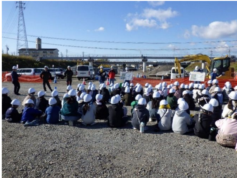
工事概要の説明
