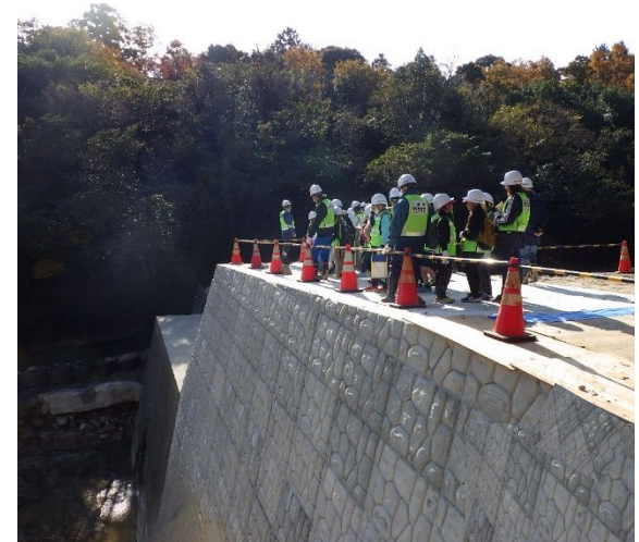
施工状況の見学
