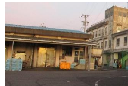
冷凍・冷蔵庫
