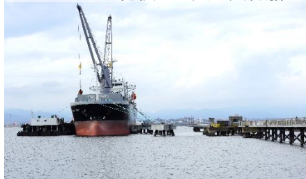
伊倉津地区の大型荷役機械
