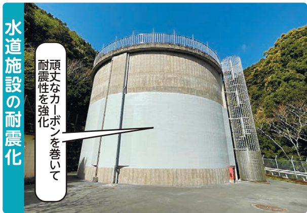
調整池（水を貯めるタンク）の耐震補強
