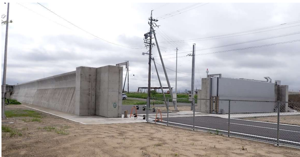
白塚漁港海岸における堤防整備
