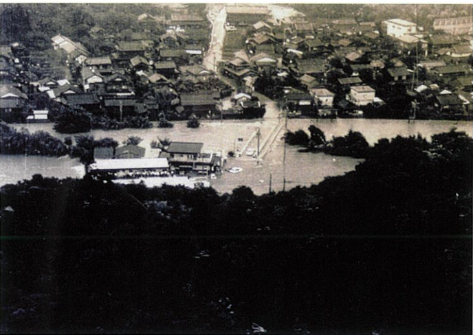
⑪ 近鉄 松尾駅 (左岸→右岸)
