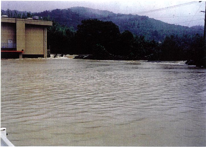
⑦ 河内町加茂川・河内川合流点・河内川溢流状況
