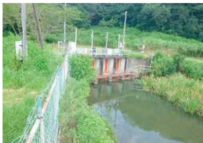
図3.2-2 三重県企業庁高野浄水場取水施設
