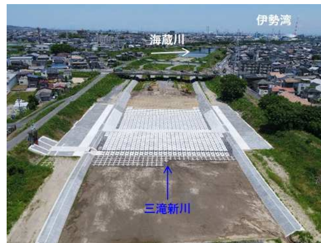
三滝新川の開削工事状況
