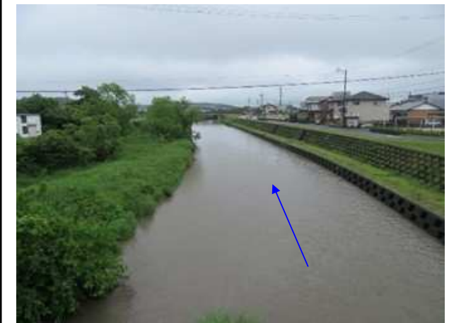
四ッ谷橋(海海四1)から下流方向
