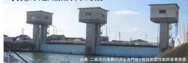
写真②：大堀川防潮水門の状況
