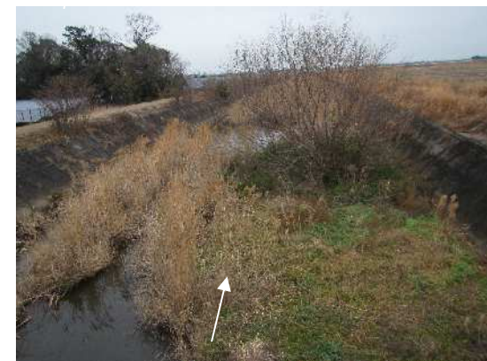
柏橋下流の河道内の状況
