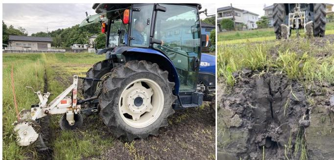
図 3. 施工された深堀明渠への弾丸暗渠の連結処理
