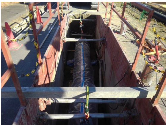
配水管布設替工事の施工状況 (松阪市)
