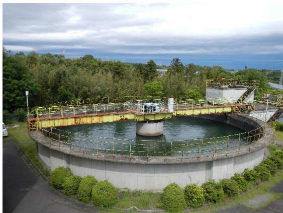
耐震補強工事を実施する伊坂浄水場 排水処理施設※（四日市市）
