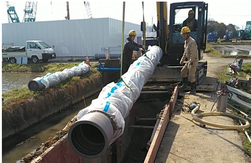
送水管布設替工事の施工状況 (桑名市)
