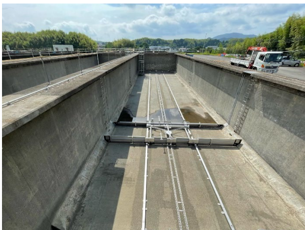
更新中の多気浄水場沈澱池汚泥掻寄機 （多気町）
