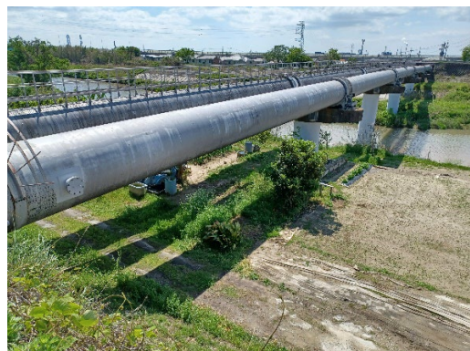
塗り替え予定の朝明川水管橋 （四日市市）
