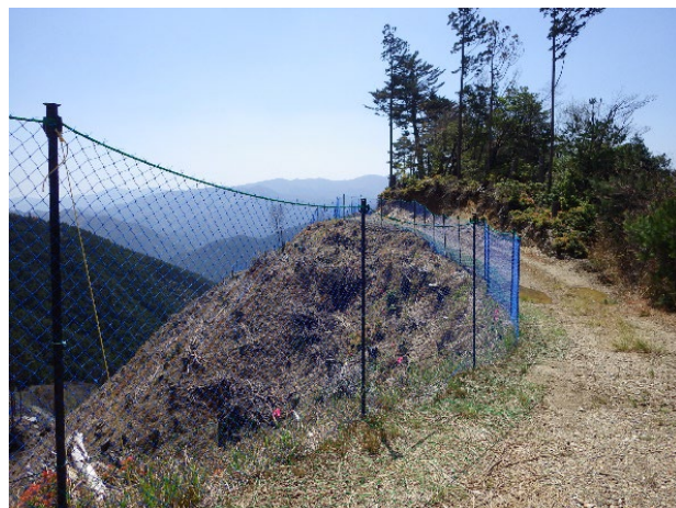
獣害防護柵の設置
