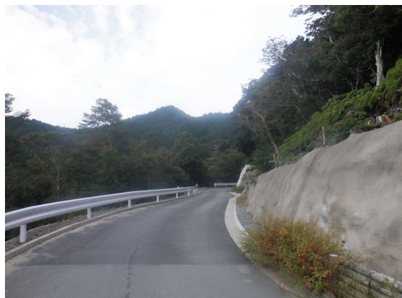
林道開設 鶴ガ坂線（度会町）
