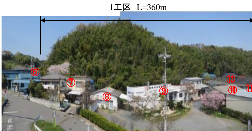
保全対象(人家)
