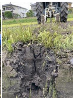
施工された深堀明渠への弾丸暗渠の連結処理
