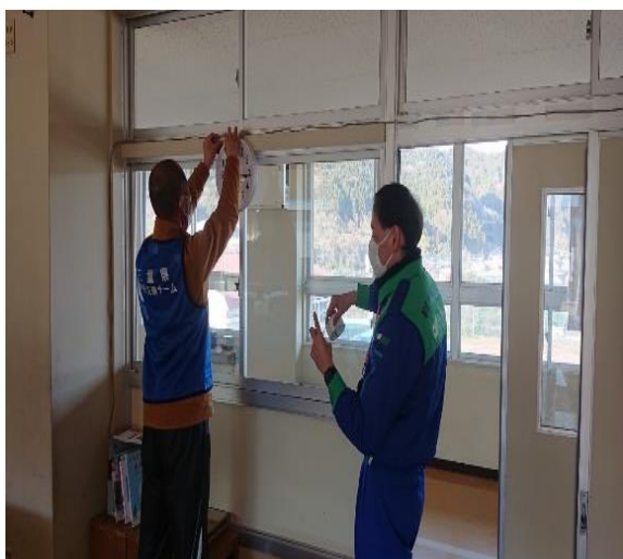
窓の改善補修
