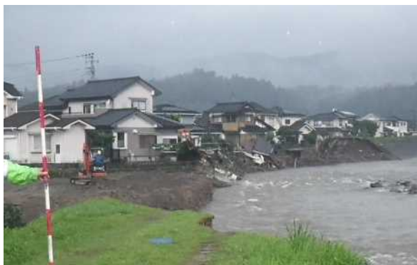
河岸侵食による家屋の倒壊(花月川)
