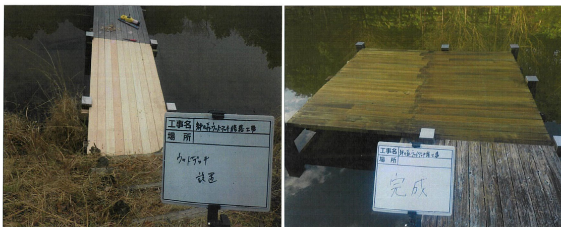
整備したウッドデッキ
