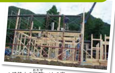
▲建設中の尾鷲ヒノキの家
