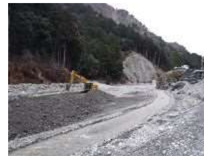
砂防堆積土砂撤去事業 (三重県)
