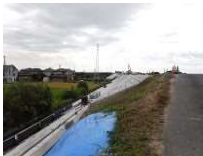
員弁川堤防強化事業 (三重県)
