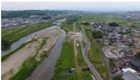
員弁川河川改修事業 (三重県)
