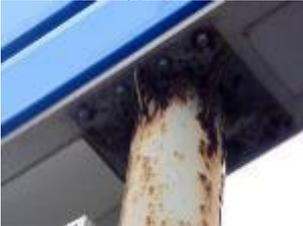
接合部（溶接部）が腐食している状態
