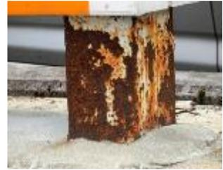
支柱根元の腐食が進行した状態
