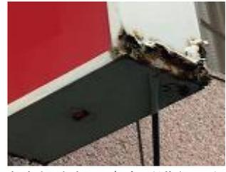
広告板底部の腐食が進行した状態
