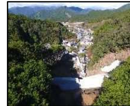
砂防堰堤の整備(猿谷) 【三重県】
