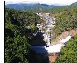
砂防堰堤の整備(猿谷) 【三重県】
