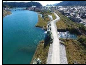
堤防強化事業(船津川) 【三重県】
