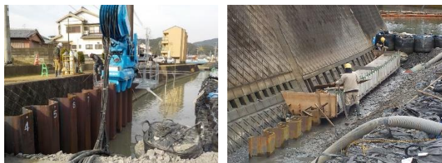
護岸整備工事施工状況
