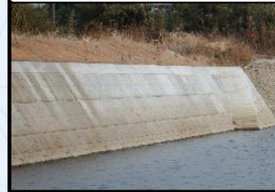
産田川護岸整備（三重県）
