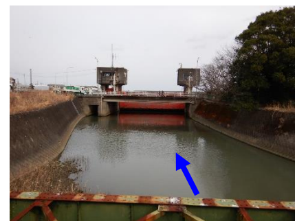
神内川防潮水門の現況
