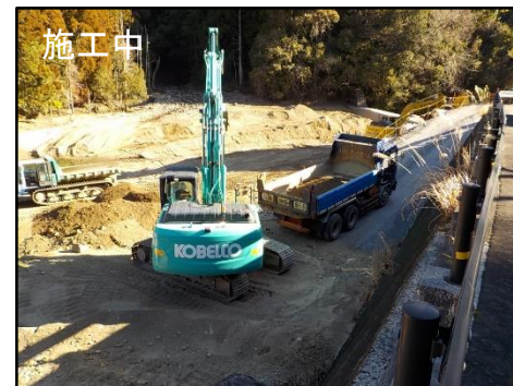
堆積土砂撤去 (井戸川) 【三重県】
