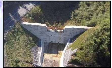
里地谷流域船谷川砂防堰堤
