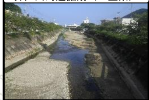
井戸川河道掘削（三重県）
