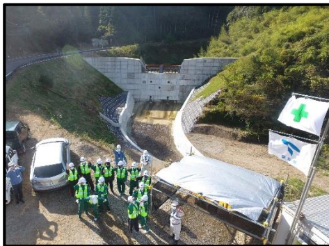
砂防堰堤の整備 (里地谷流域船谷川) 【三重県】
