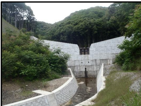
砂防堰堤の整備 (ヨドロ崎) 【三重県】
