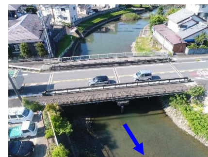
波静橋の現況
