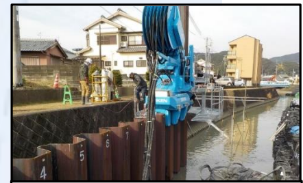
神内川護岸整備状況 (紀宝町役場付近護岸整備工事)
