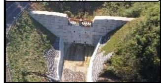
里地谷流域船谷川砂防堰堤整備（三重県）
